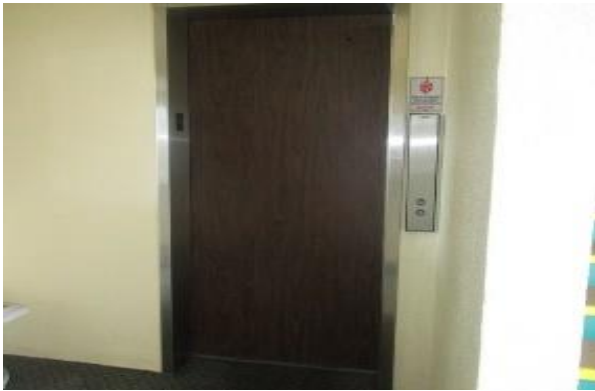
27 Elevator Door Overview
